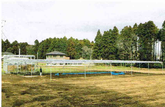
太陽光を農業と発電で分け合うことからソーラーシェアリングと呼ぶ。 (上) ブルーベリーのポッド栽培を行うビニールハウス20㎡で3kWhを発電。 ポンプや換気扇の電力を自給できる。付加価値の高いブルーベリーは農業 初心者にもおすすめ。(下) 670㎡の農地で25kWhを発電。
